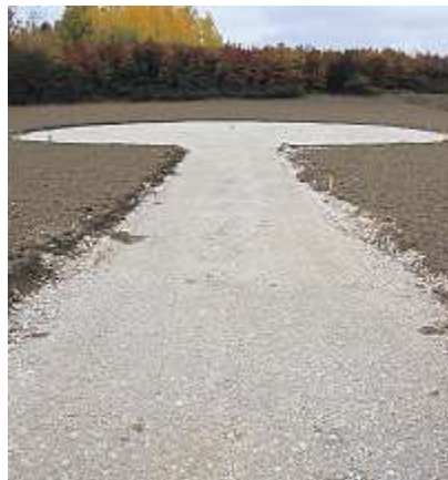
Der Platz für die künftige Feuerstelle ist bereits befestigt.
